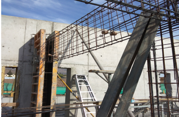
Instalación de moldaje muro eje J/13-16, piso 2, sector terraza descubierta.
