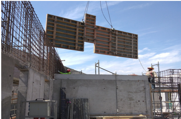
Instalación de moldaje muro eje 6/H3-K, piso 2, etapa 2, sector casa parroquial.
