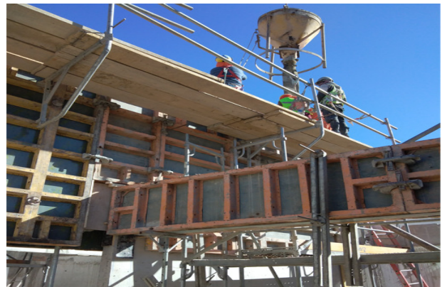
Hormigonado de muro eje 6/H3-K, piso 2, etapa 2 coronamiento, sector casa parroquial.
