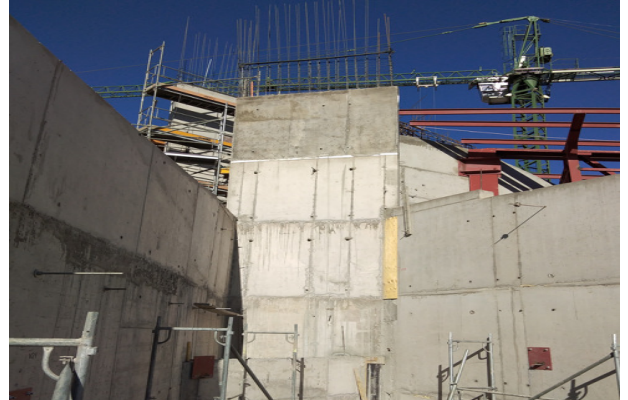
Descimbre muro eje T1/5-18, etapa 4, campanario.
