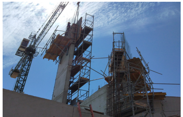
Descimbre muro eje L/5-9, etapa 4, campanario.
