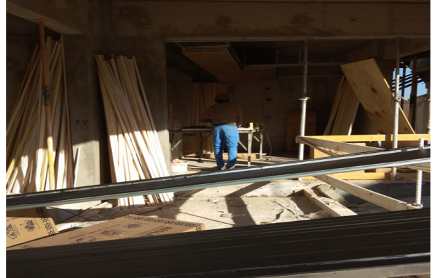
Avance fabricación de paneles para cielo de madera del templo mayor.
