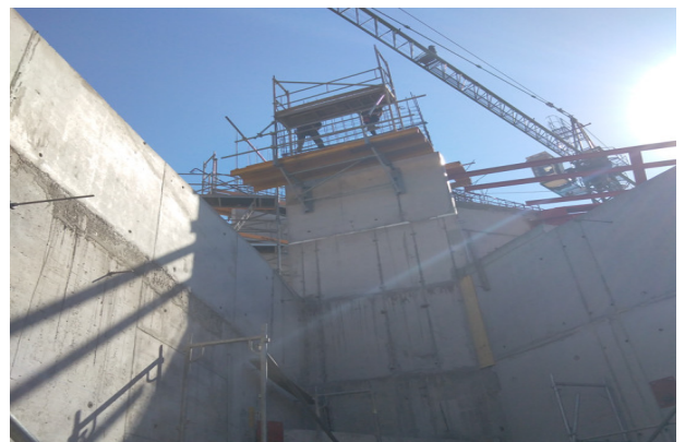
Avance armadura muro eje T1/5-18, etapa 5, campanario.
