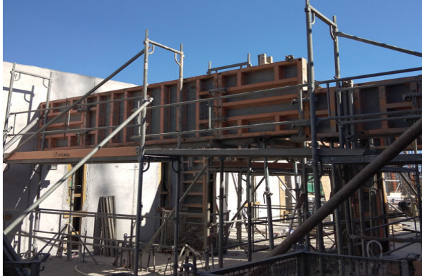
Instalación de moldaje viga eje H3/6-16, cielo piso 2, sector terraza descubierta.
