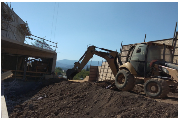
Excavación para nivelación de terreno, jardín nor-oriente.
