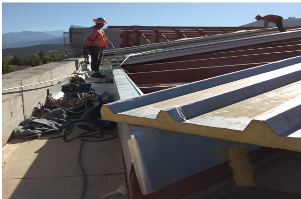
Instalación de panel Kover, cubierta templo mayor, sector acceso N°02.
