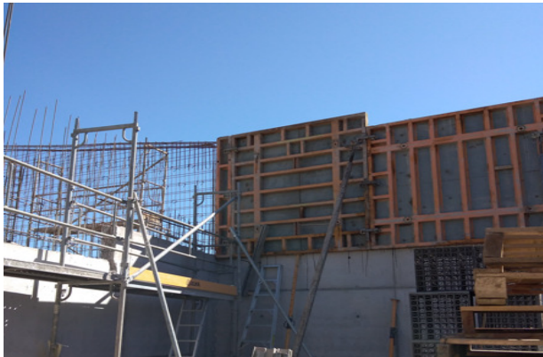
Instalación de moldaje 2° cara, muro eje Q/5-16, piso 2, sector talleres.
