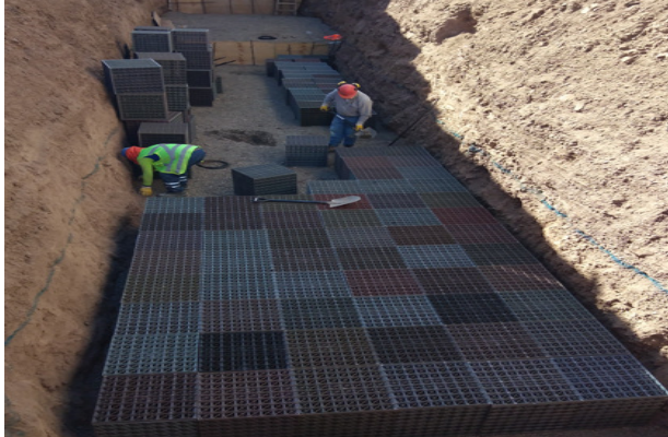
Instalación de cubodren para zanja drenante, sector deslinde nor-oriental.
