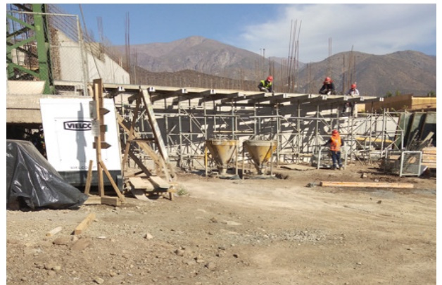
Instalación de envigado para muro invertido eje 19a/L-Y1, piso 1, templo menor.
