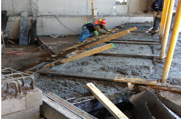
Hormigonado de escalera N° 03, acceso templo mayor.
