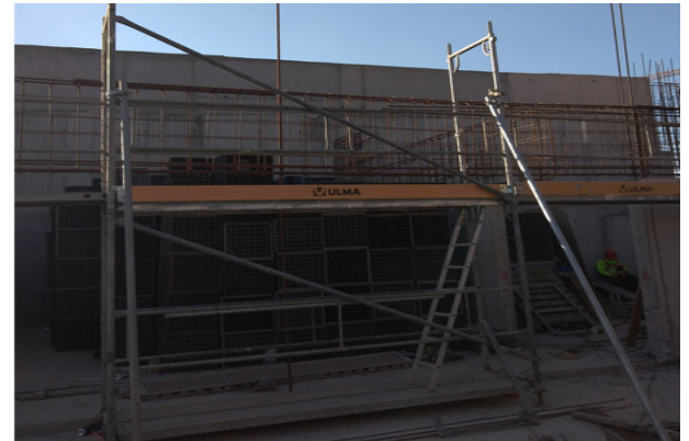
Avance armadura viga eje 12/D-I, piso 2, sector patio talleres.
