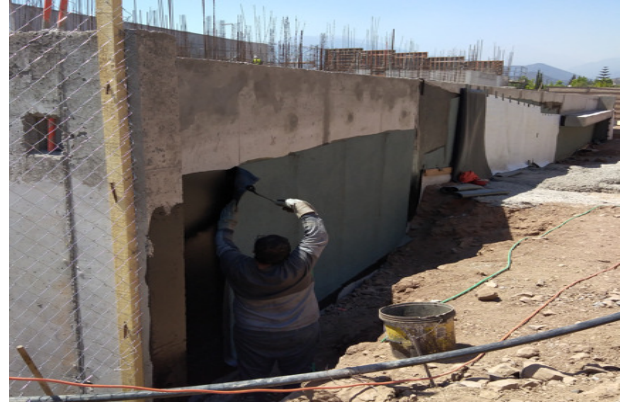
Colocación de membrana asfáltica en muro eje 17/K-Y1, piso 1.
