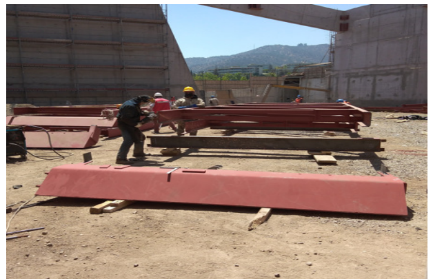
Proceso de soldadura de tramos de cerchas ER04-ER05-ER06, viga A2.
