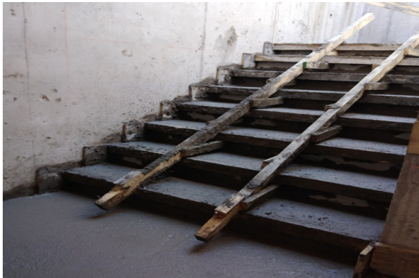
Hormigonado de escalera N°01, tramo 02, sector ascensor.
