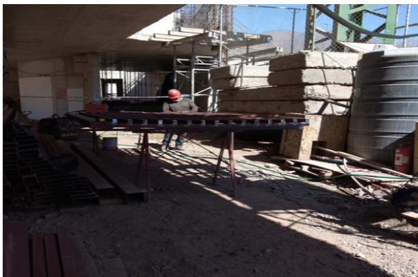
Avance carpintería metálica, confección de portón PM1.
