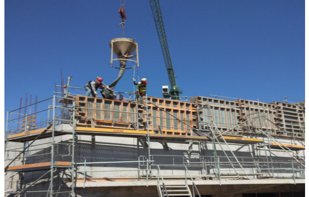
Hormigonado de muro eje Q/5-16, piso 2, sector talleres.
