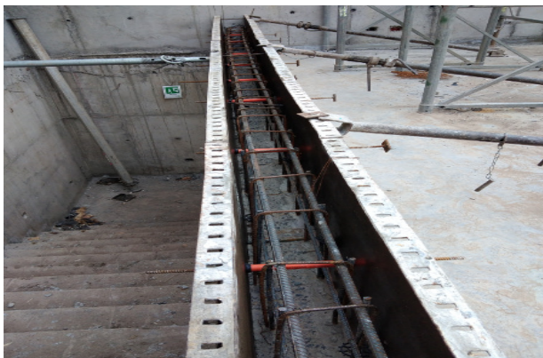
Instalación de moldaje en antepecho sector escalera al coro, piso 2, Templo mayor.
