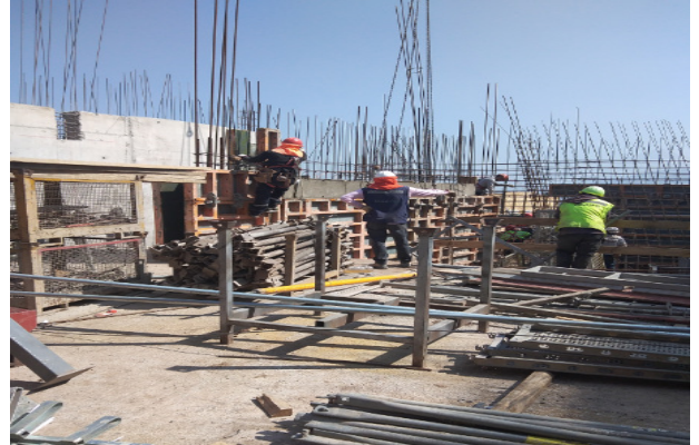
Descimbre muro eje P//8, piso 1, Templo menor.
