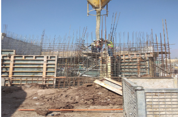
Hormigonado muro eje X/P-Y1, piso 1, Templo menor.
