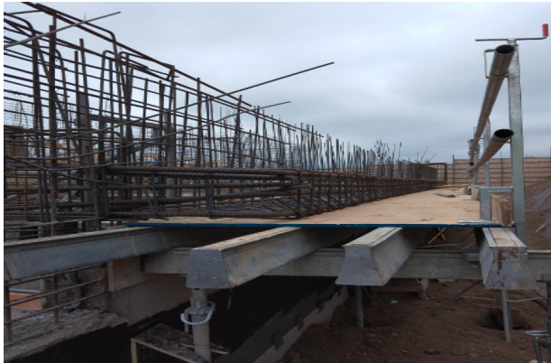
Avance armadura viga eje 17/G-K, refuerzo muro de contención contra terreno.
