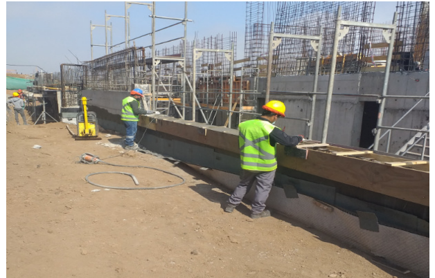
Hormigonado coronamiento muro eje 17/C-G, piso 1.
