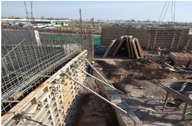
Instalación de moldaje 2º cara, muro eje 20/L-Y1, piso 1, Templo menor.
