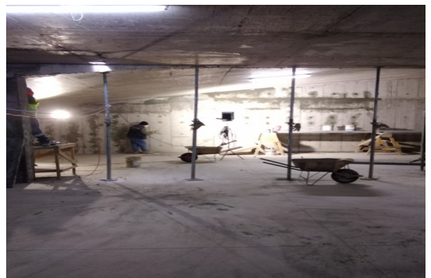
Descarachado y maillaje muro eje 17/J2-Y1, nivel subterráneo, sector rampa vehicular.
