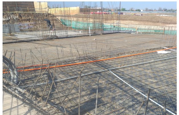
Avance malla inferior losa cielo piso 1, sector velatorio 1y sacristía templo menor.
