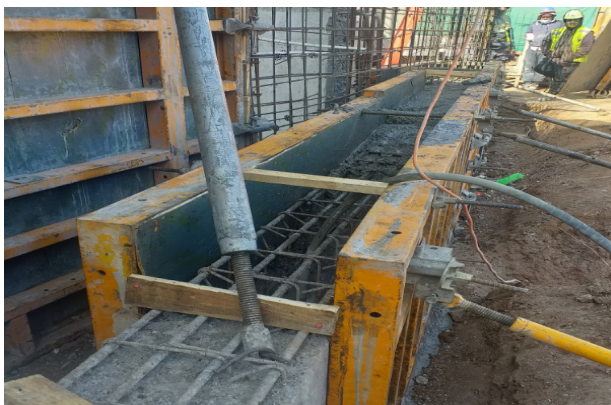
Hormigonado cadena de fundación eje 19a/N-Y1, piso 1, templo menor.
