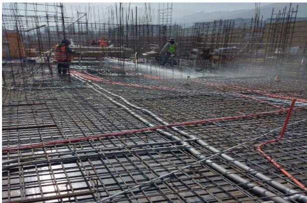
Limpieza de placas, losa cielo piso 1, ejes H1-Y/6-16.
