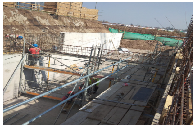
Avance armadura vigas eje J y K/16-17, sector rampa vehicular.
