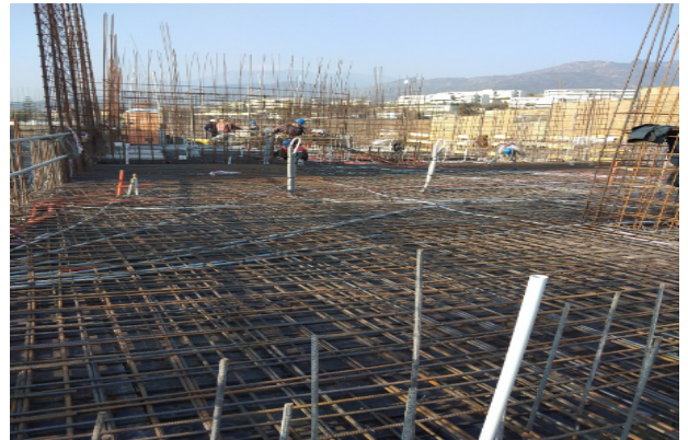
Avance malla refuerzo superior losa cielo piso 1, ejes H1-Y/6-16.
